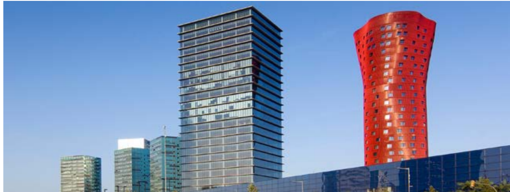
Torre REALIA (Barcelona)
